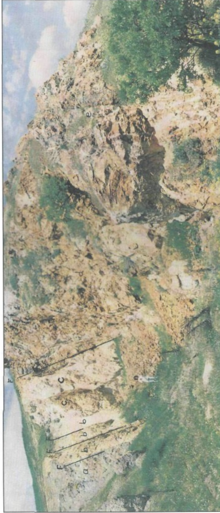
Şek. 4- Gıcık yarmasında gözlenen zonlar: a- ana kaya (andezit), b- az kılı zonu, c- çok kılı zonu, d- fay zonu, e- silisli zonu, f- fay
